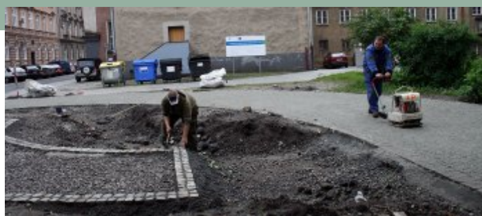
Foto Dorota Havlíková: Dělníci dokončují zpevněné plochy. Protože jde o historický střed města, zvolil architekt žulové kostky
