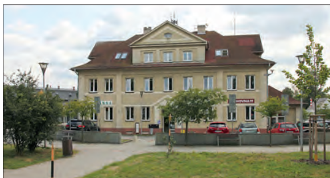
Výměna oken v domě č. 369 na náměstí Dr. Brauna
