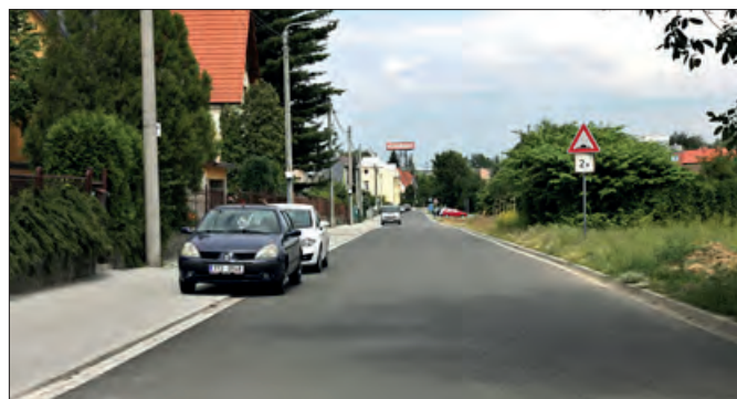
Opravy komunikací a chodníků po rekonstrukci
