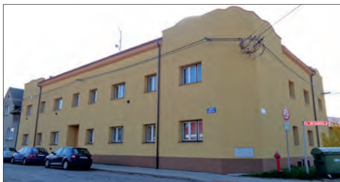
Zateplení domu č. 55 na ulici Bratří Sedláčků
