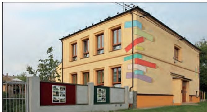
Zateplení budovy mateřské školy na ul. Polanecké
