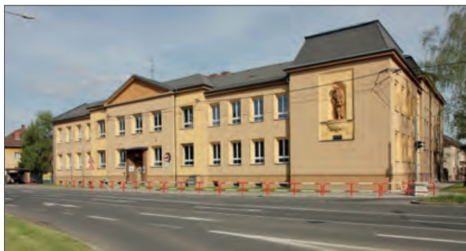
Zateplení budovy základní umělecké školy na ul. Bílovecká 1
