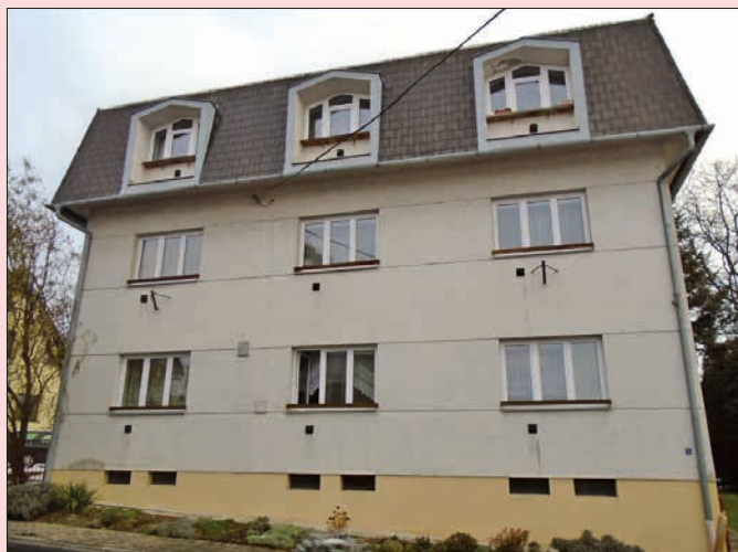
Naši spoluobčané v domě č. p. 679/2 na ul. U Rourovny mají od letošního podzimu nová okna
