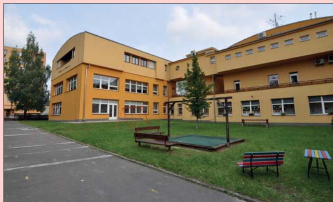
Zateplení MŠ E. Rošického 1082
