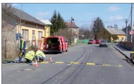
Instalace zpomalovacího prahu na ul. Bří. Sedláčků
