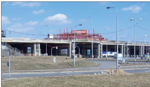
Svinovské mosty - rekonstrukce třetího pole jižního mostu
