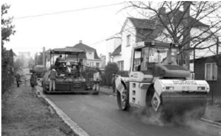
Pokládka a hutnění finální asfaltové vrstvy
