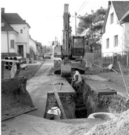
Ul. Lelkova – oprava kanalizace
