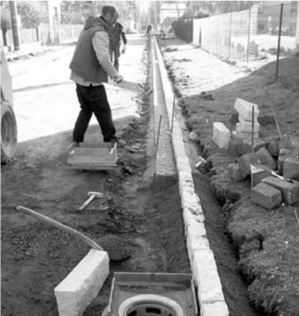
Ul. Mičurinova – pokládka obrub, dvojřádku, výměna dešťových šachet
