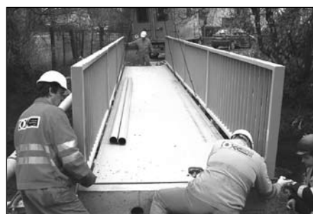
Usazení nové lávky přes Porubku 11. dubna 2008
