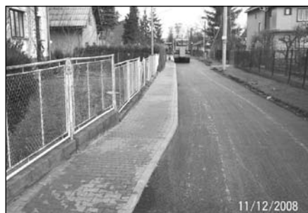
Oprava chodníku a komunikace – ul. Zátíši
