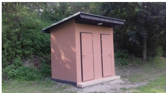
▲► Obr. Nové WC v areálu střelnice
