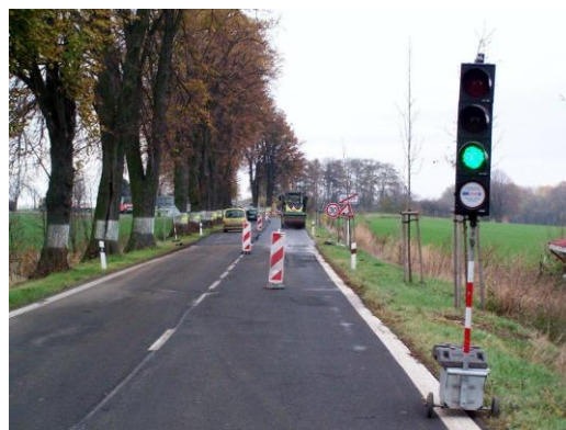
Obr. ▲ Oprava komunikace I/46 v Sudicích
