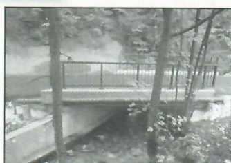
Rekonstrukce mostu v K. Lhotce.
