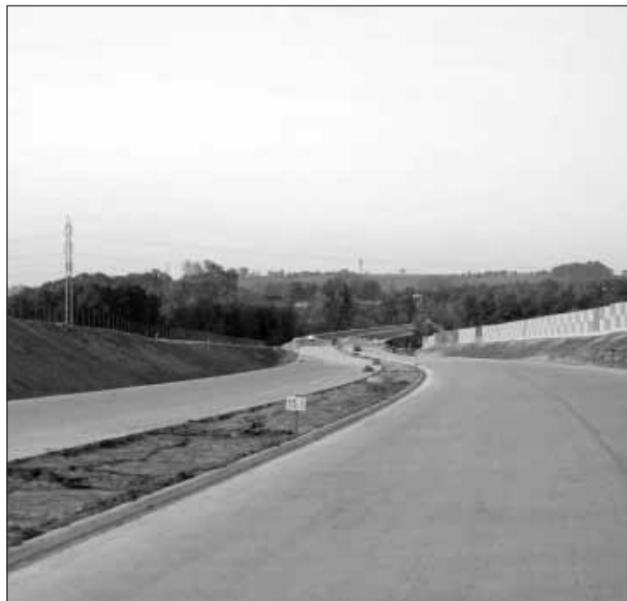
Foto z výstavby úseku Tošanovice – Žukov.
