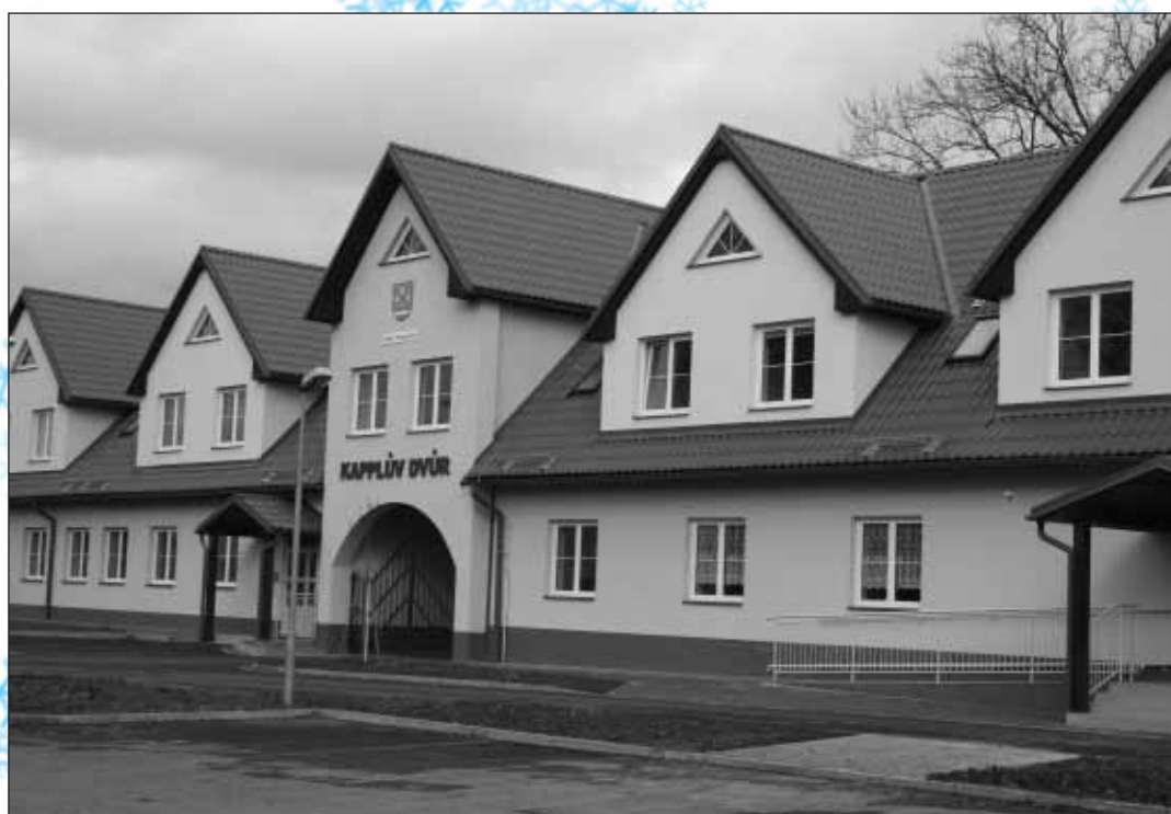
Chátrající budovy v Třanovicích dostaly novou tvář
