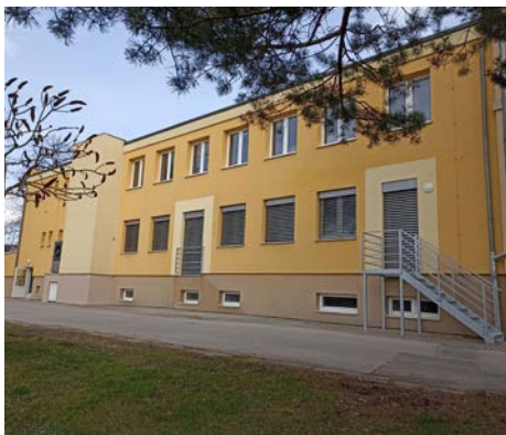
Rekonstrukce části obecního úřadu a přeměna na Dětskou skupinu
