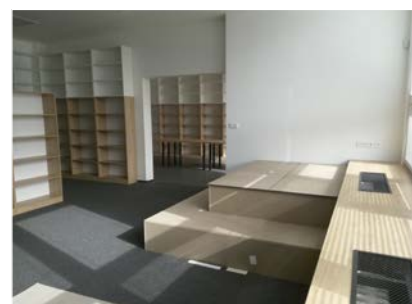
Rekonstrukce obecní knihovny
