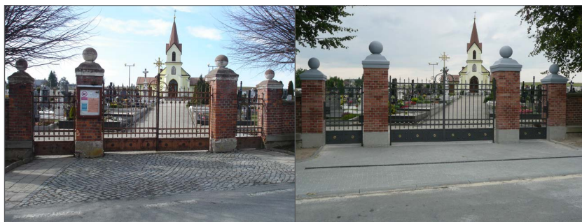
Vstup hřbitova před (vlevo) a po rekonstrukci
