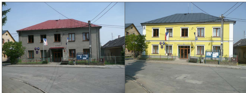
Budova obecního úřadu před (vlevo) a po rekonstrukci
