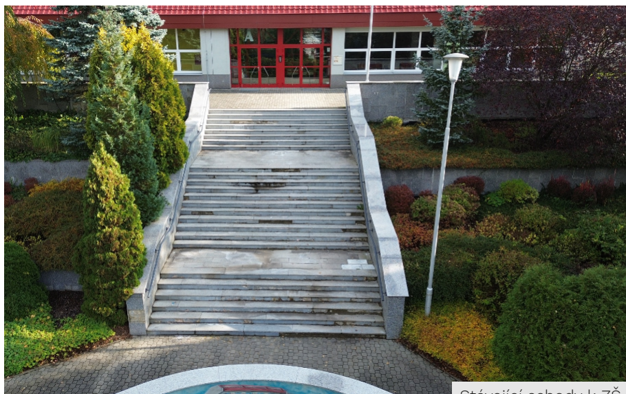
Stávající schody k ZŠ
