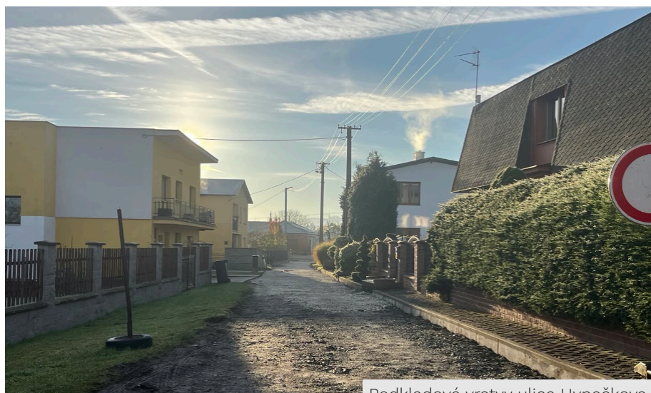
Podkladové vrstvy ulice Hynečkova
