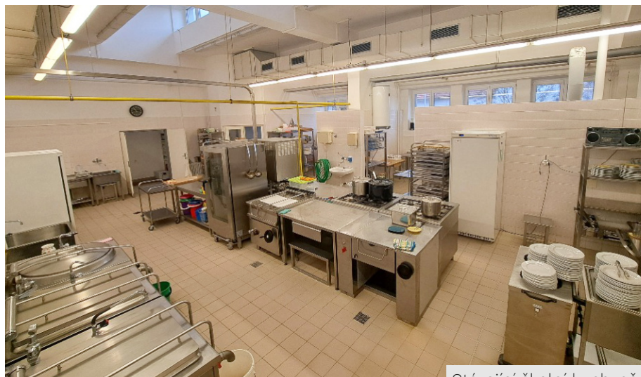
Stávající školní kuchyně
