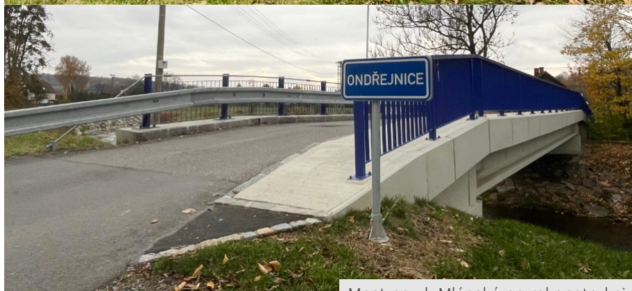
Most na ul. Mlýnská po rekonstrukci
