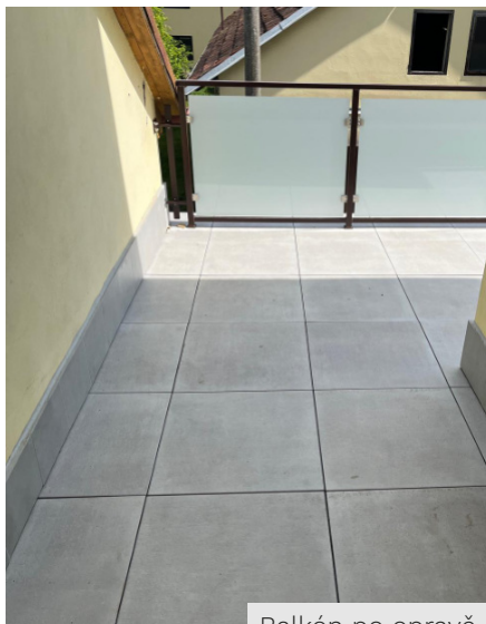
Balkón po opravě
