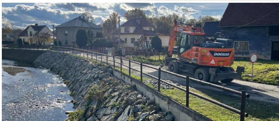
Ulice U Vody s již vybudovaným novým břehem průjezdným od listopadu 2024
