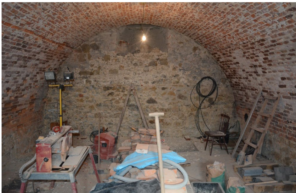
Rekonstrukce sklepních prostor zámku
