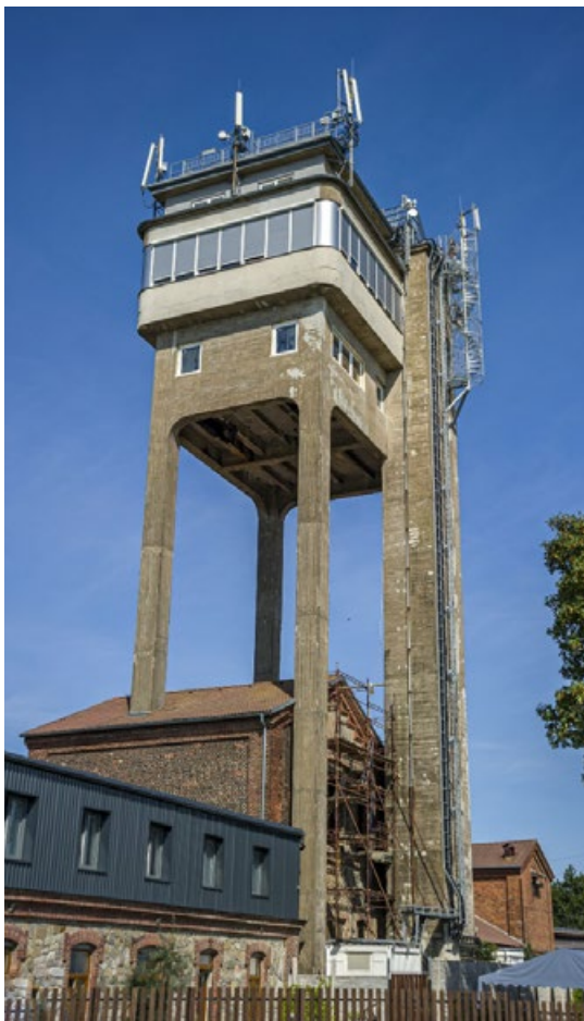
Věž Rudolfka Bohutín
