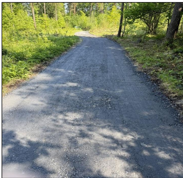
stav po opravě
