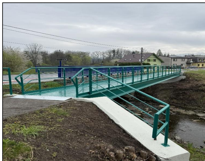
stav po opravě
