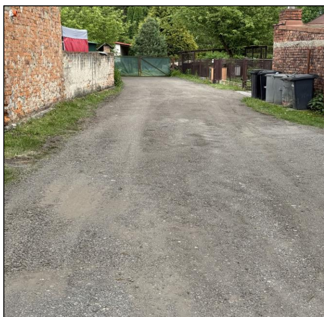
stav po opravě
