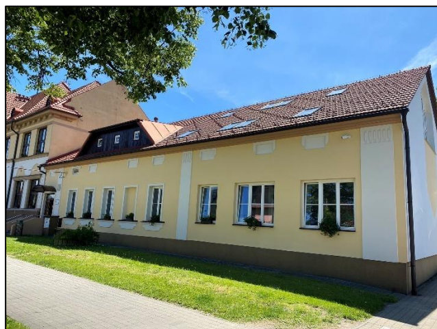
Opravený a nově natřený objekt ZŠ
