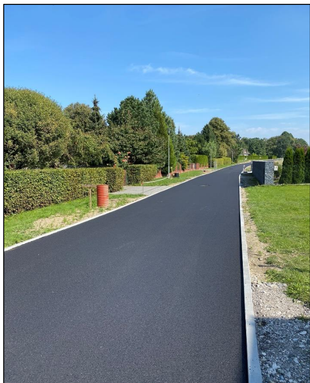
Nová místní komunikace U Chodníčku - nad hřištěm před dokončením
