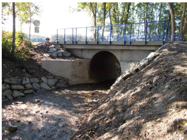
Stav po rekonstrukci
