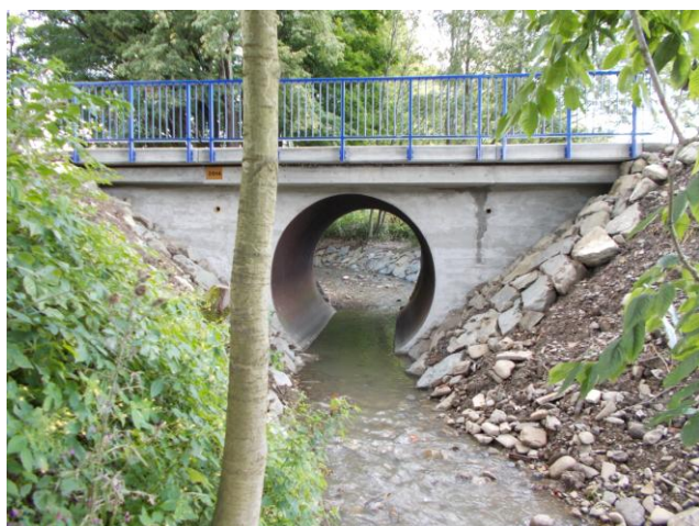
Stav po rekonstrukci
