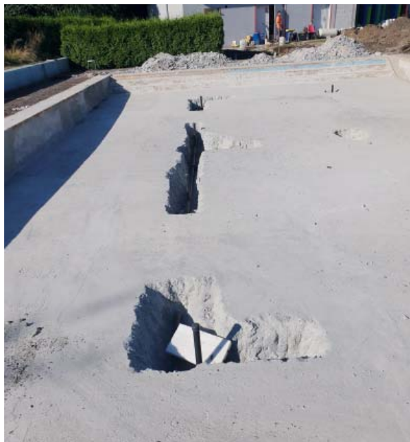
Oprava poškozeného potrubí. Hlavní odkryté vady se týkaly malého bazénu.
