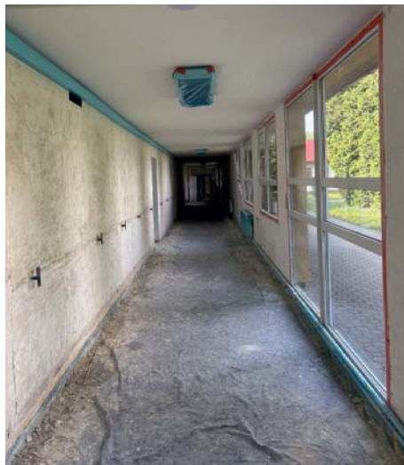
Dlouhá spojovací chodba během rekonstrukce.
