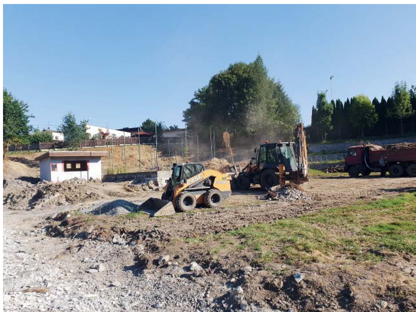
Zadní část byla silně podmáčená – dočkala se tedy odvodnění i dalších terénních úprav.
