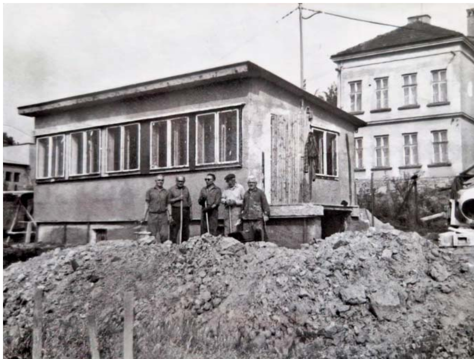
Klubovna včelařů má více než půl století, teď potřebuje opravit – střechou do ní zatékalo.
