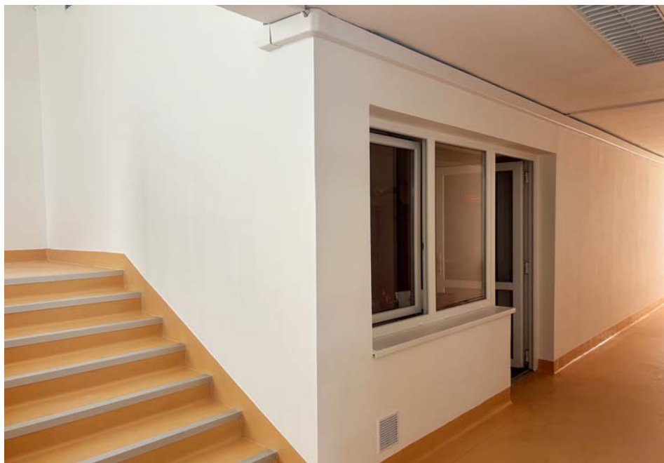
Po opravách. Na stěnách nové omítky, veškeré kabely jsou v lištách.
