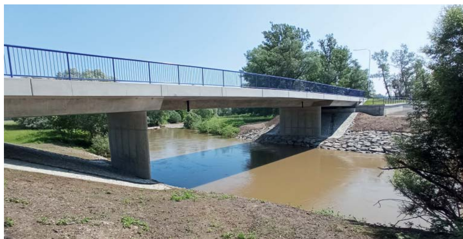
Pohled na nový most z levého břehu.
