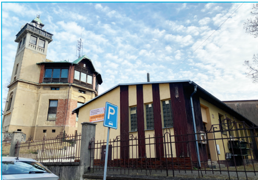
Budova na adrese Chittussiho 1992/6, pro kterou Slezská Ostrava hledá využití.
