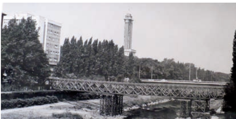
Provizorní železná lávka pro trolejbusovou dopravu v mezidobí stavby nového mostu v letech 1976–1986.
