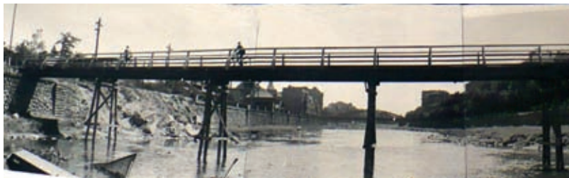
Provizorní dřevěná lávka vybudovaná těsně po 2. světové válce.
