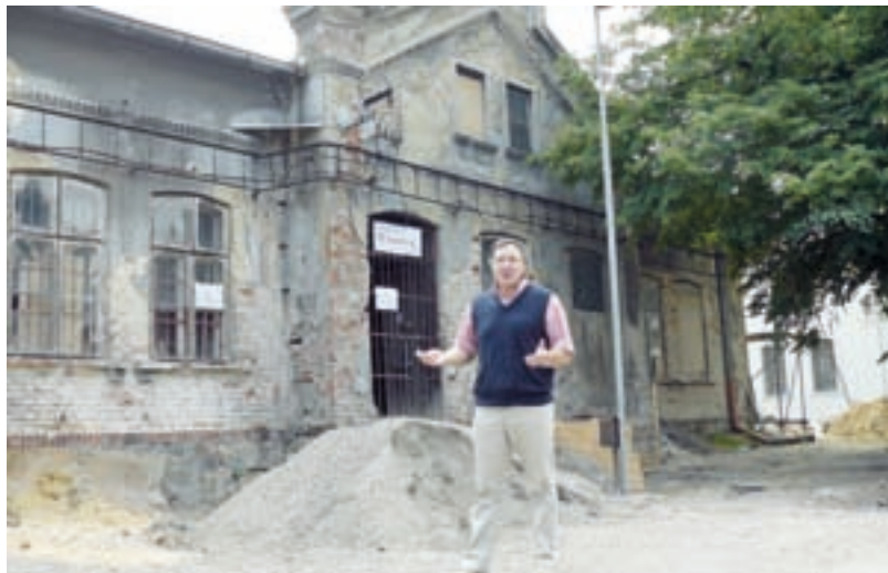
REKONSTRUKCE. Ředitel Pavel Folt před administrativní budovou. Oprava kulturní památky začala. FOTO / JAN KRÁL
