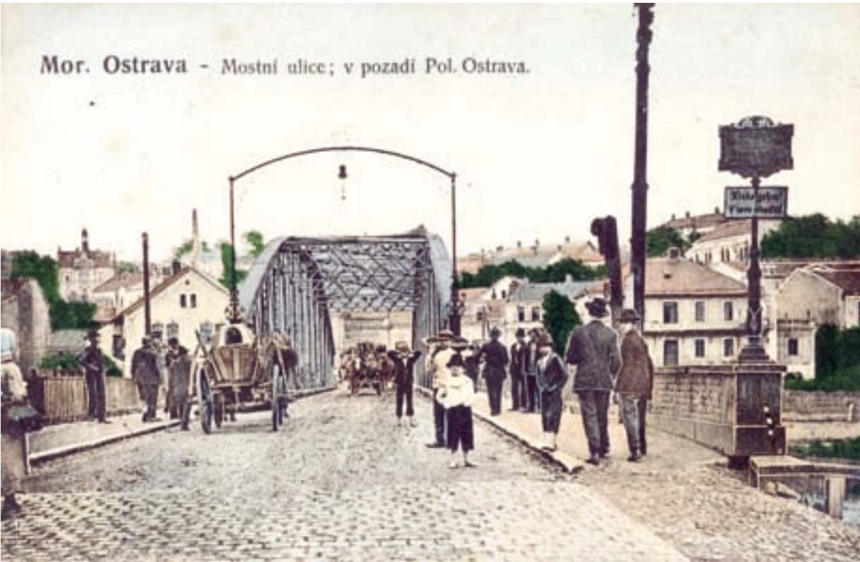
Tento malebný žánrový obrázek Říšského mostu s okolím vydal nakladatel Karel Mareš okolo roku 1910. Most v popředí vznikl dva roky po zřícení řetězového mostu-tragedií, které se udála v roce 1886. Nově projektovaná stavební konstrukce byla ocelová a nýtovaná. Most měl délku 92 metry a po obou stranách chodníky. V provozu byl do roku 1912, tedy poměrně krátkou dobu. Jeho demontáž byla zdůvodňována sníženou únosností. Brzy nato začala výstavba nového mostu, dnešního mostu Miloše Sýkory, který byl uveden do provozu v roce 1915. Na pravé straně mostu se nachází starobylá lékárna U sv.Prokopa, po levé straně mostu, úplně na horizontu, je patrná budova I. společ. Knih-a kamenotiskárny, od roku 1910 pak knihtiskárna UNION. Byla to první česká tiskárna ve Slezsku. Budova z let 1898-1899 byla dvoupatrová a její fasáda měla neorenesanční prvky. Za druhé světové války, byla bombardováním poškozena a prošla několika stavebními úpravami. V silně pozměněné podobě stojí dodnes na Sazečské ulici. Nachází se v ní firma Atoll – Electronic spol. s.r.o. Havířov GALVANOVA. Kromě tiskopisů a kalendářů se v tiskárně do roku 1917 tiskl také Ostravský deník a právě zde byly vytištěny i Dějiny Polské Ostravy.
