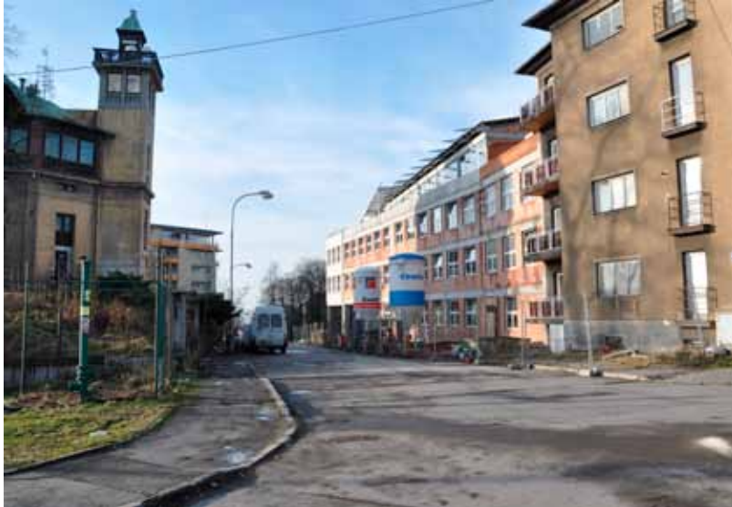
STUDENTI A HLODAVCI. Hrubá stavba moderní budovy Přírodovědecké fakulty Ostravské univerzity na Chittussiho ulici už je hotova. Součástí nových prostor bude i zvěřinec.
