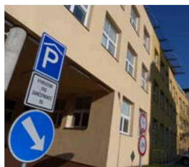
CENTRUM. Nová budova univerzity jako součást nově vznikajícího centra Slezské Ostravy. FOTO/JAN KRÁL
