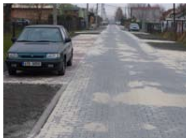
Opravená ulice Nad Vodárnou v Heřmanicích.
