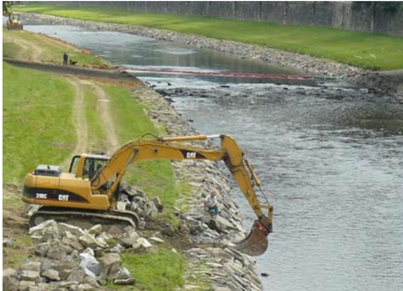
REVITALIZACE. Těžká technika vyrazila na slezskoostravské břehy řeky Ostravice. FOTO/JAN KRÁL
