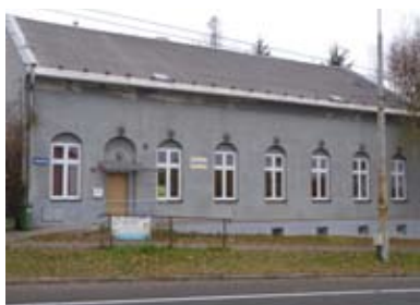
Nová okna v knihovně na Hladnovské.
