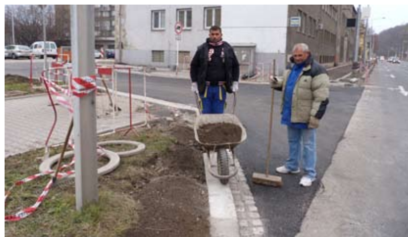
Úprava vjezdu na parkoviště Bohumínská ulice.
