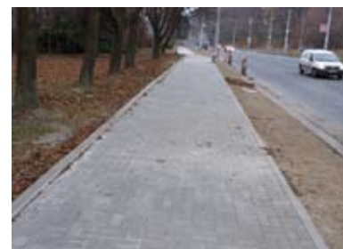
Opravený chodník na Bohumínské.
