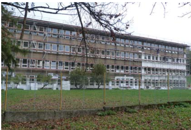
Oprava ZŠ Bohumínská.
