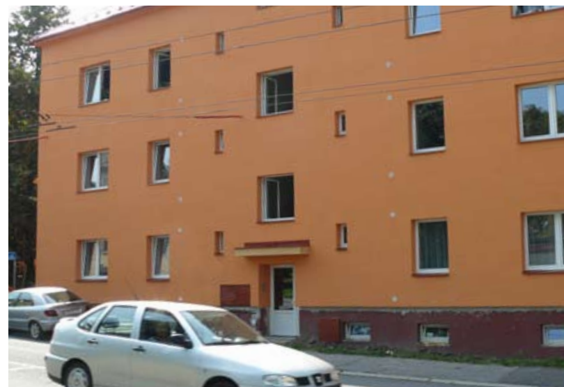
Opravený Dům s pečovatelskou službou Heřmanická.
