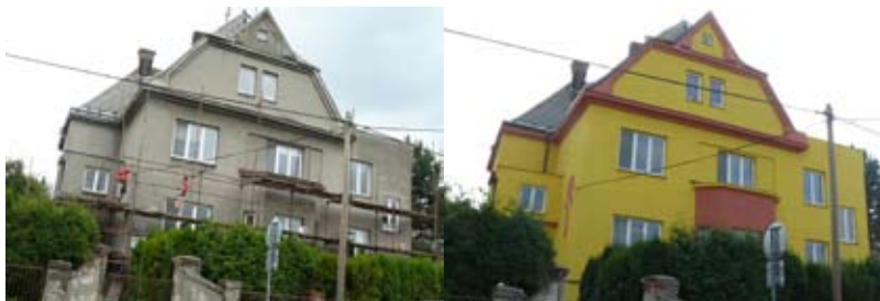
OPRAVENO. Mateřská škola Jaklovecká před opravou a po opravě.
