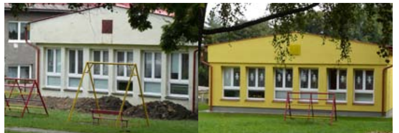
OPRAVENO. Mateřská škola Chrustova před opravou a po opravě
