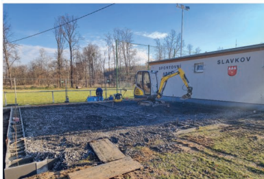
Základy přístavby garáže u TJ Sokol Slavkov
