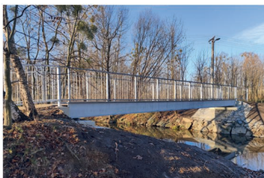
Nová lávka přes řeku Hvozdnici
