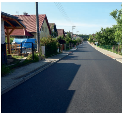
Ulice Zahradní po rekonstrukci
