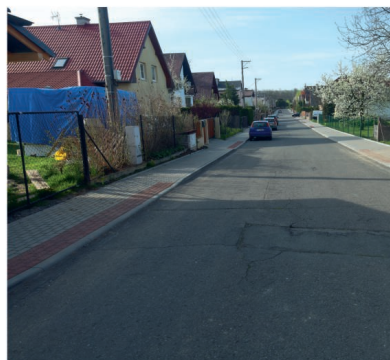
Ulice Zahradní před rekonstrukcí
