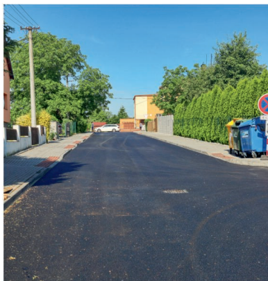
Ulice U Dráhy po rekonstrukci
