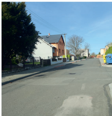
Ulice U Dráhy před rekonstrukcí
