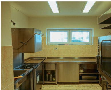
Kuchyňka v kulturním domě před rekonstrukcí
