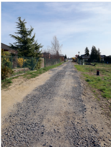
Ulice Pod Areálem před výstavbou nové cesty a chodníku
