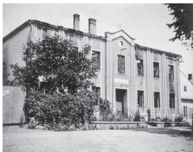
Budova školy a Obecního úřadu po roce 1945 - dnes MŠ
