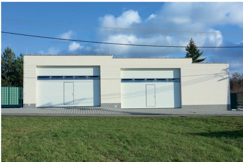
Nové garáže na Černé cestě
