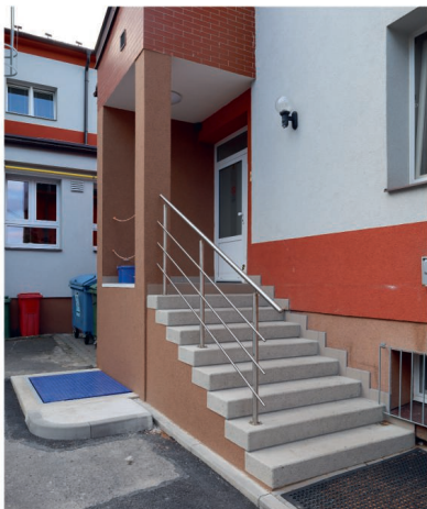
Po rekonstrukci s nově vybudovaným výtahem
