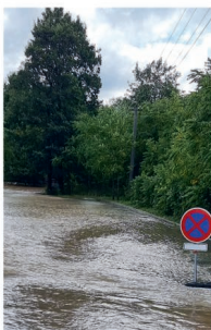
Zatopené parkoviště u fotbalového hřiště
