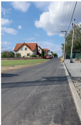
Nový asfaltový povrch u ČOV
