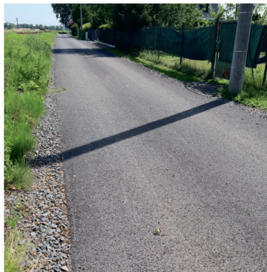
komunikace v Trníně po rekonstrukci
