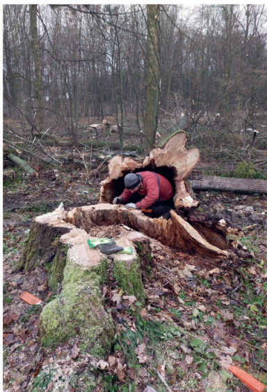
Některé pokácené stromy byly opravdu ve špatném stavu
