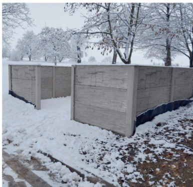
nové stanoviště na kontejnery na tříděný odpad u hřbitova
