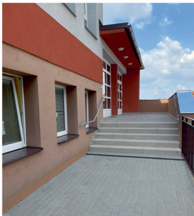
schody u školní jídelny po rekonstrukci
