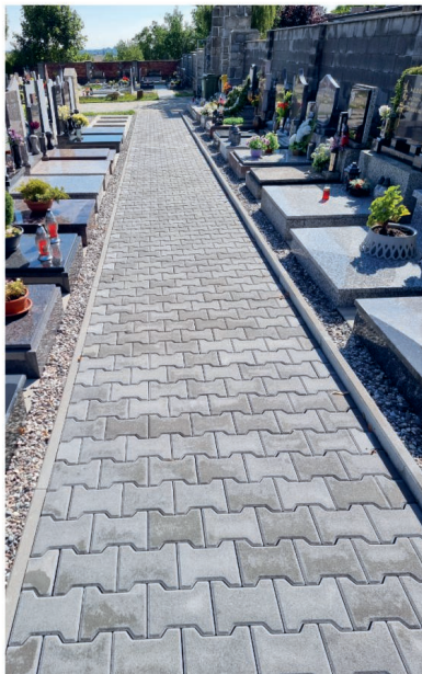
výstavba chodníků na hřbitově
