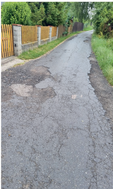
ulice K Srdečníku před rekonstrukcí
