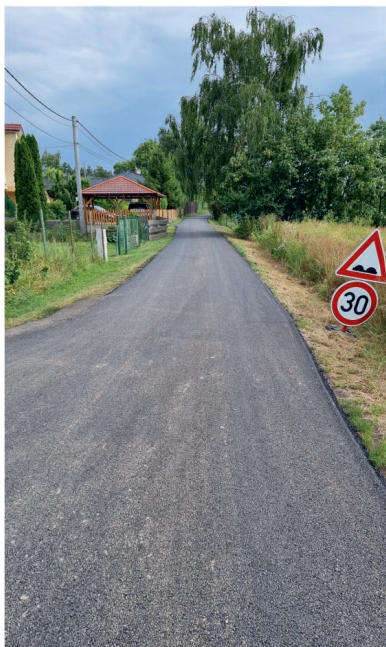
ulice K Srdečníku po rekonstrukci
