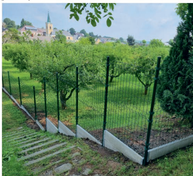
plot u školy po rekonstrukci
