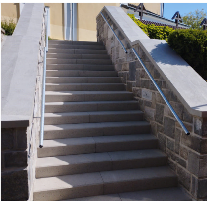
Schodiště u kostela po rekonstrukci
