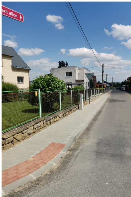
Stará ulice po rekonstrukci chodníků
