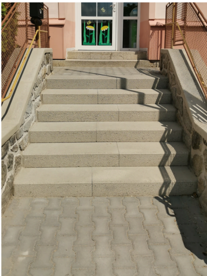
MŠ schody po rekonstrukci
