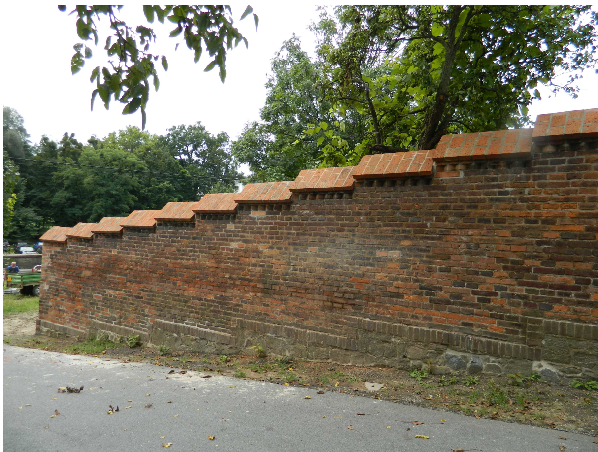
Oprava opěrné zdi ulice Ovocná
