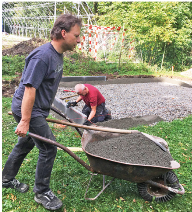
Výbor SDH Paskov Příprava základů na dráze
