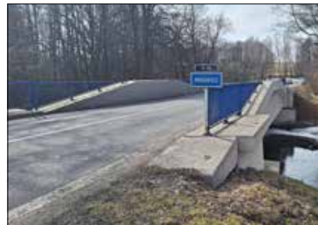
demolice stávajícího mostu z roku 1925 a výstavba nových konstrukcí.
