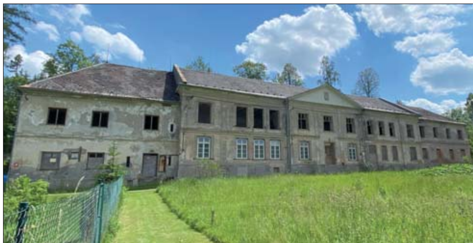
Dům č. 191 (dnešní Na Poliře 191) sloužící jako sídlo stanice po vzniku Československa, archiv autora
