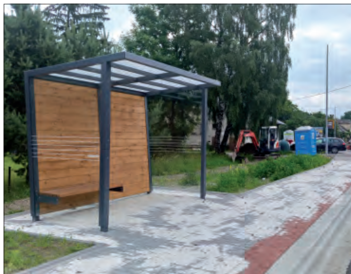
Nový chodník v Edrovicích s autobusovou zastávkou
