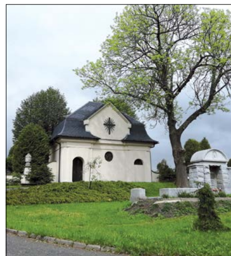
Kaple po opravě
