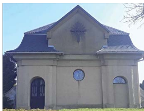
Hřbitovní kaple před opravou
