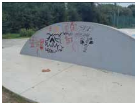
Skatepark poškozený vandaly
