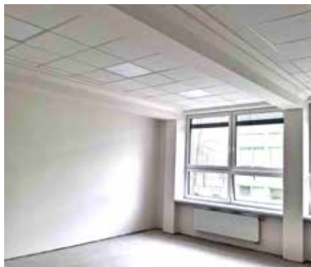
Výstavba školního pavilonu se blíží do poslední fáze
