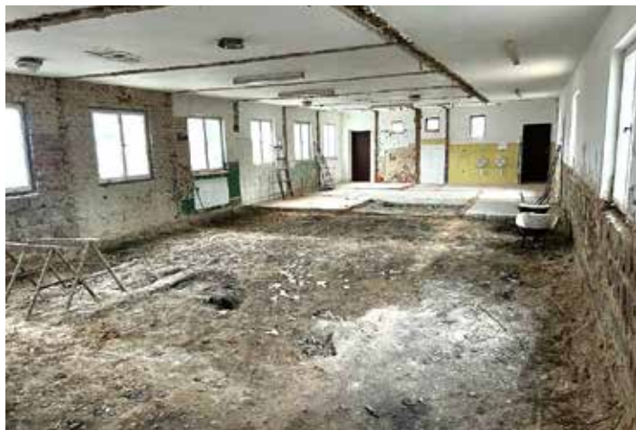
Krátce po zahájení rekonstrukce
