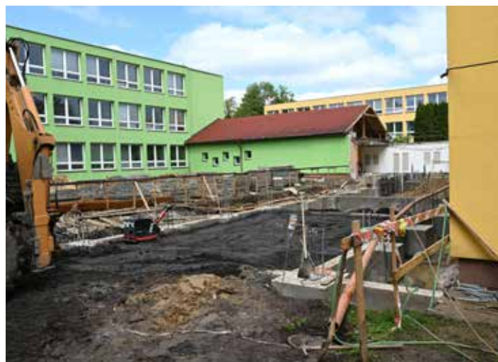
Přístavba pavilonu školy běží podle plánu
