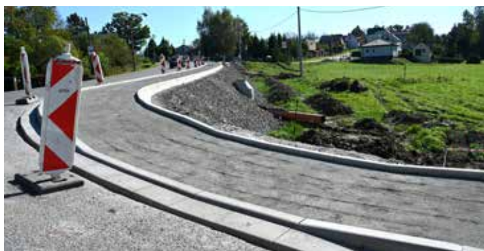
Stavba chodníku se propojila i s přeložkami sítí
